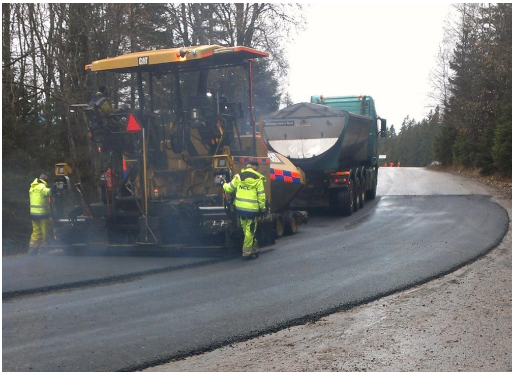
Figur 12 visar pågående läggning av provyta (Foto: Rebecka Magnusson, 2012).
